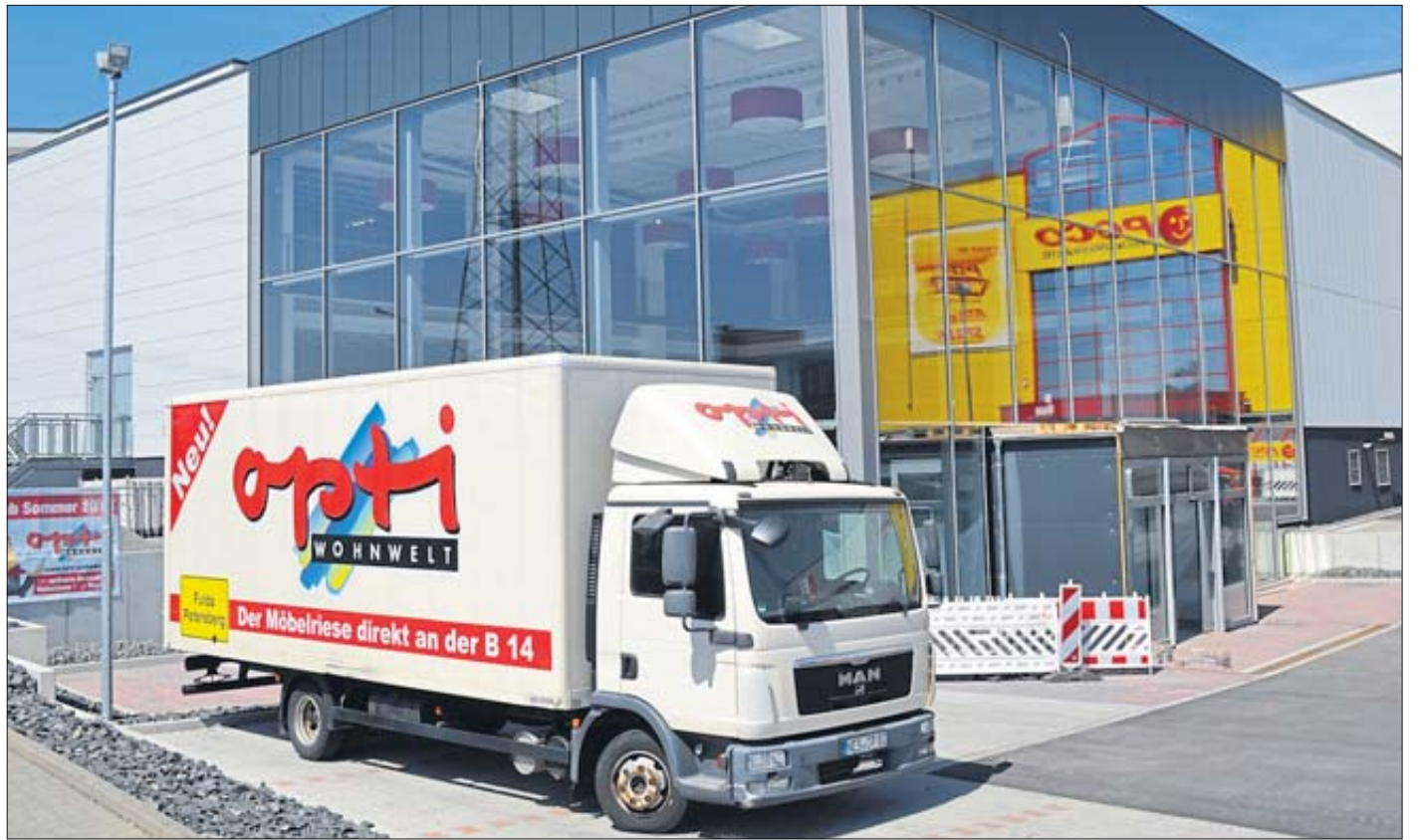
Für den neuen Mieter Opti-Wohnwelt wurde ein zusätzlicher Eingang geschaffen.
